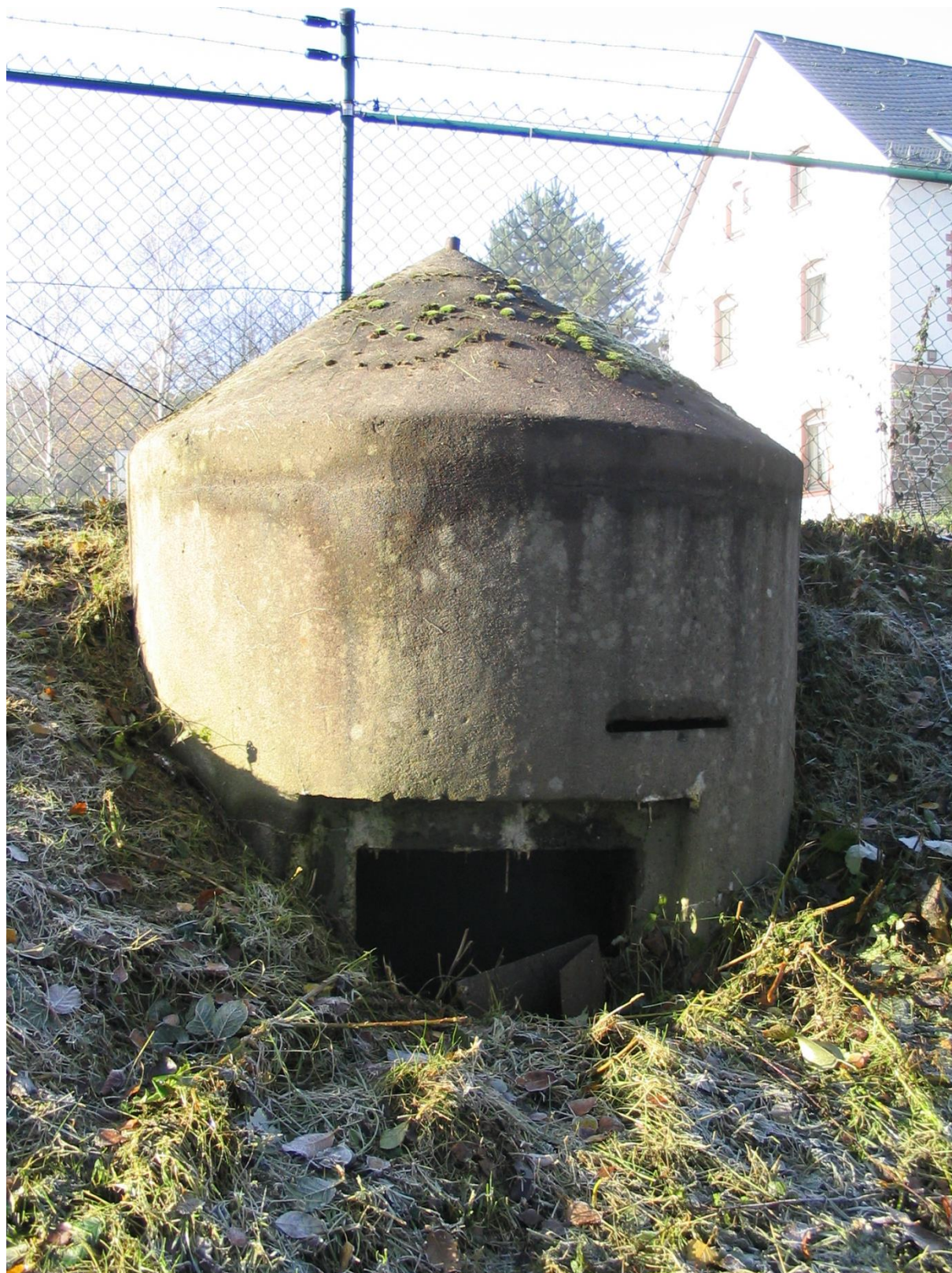
Eine sog. Splitterschutzzelle - ein aus Beton gefertigter Einmannbunker - auf dem Gelände der Steuler Industriewerke in Höhr-Grenzhausen.
